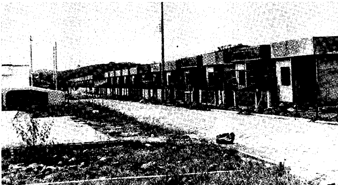
Terceira fase de construção do bairro Vila Valverde. As novas unidades são maiores (3 quartos) e suas estruturas permitem ampliações para mais um andar.
