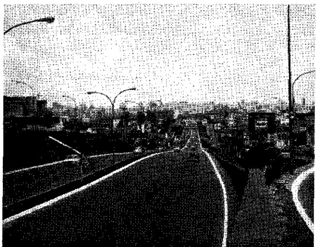
Foto 5 — Trecho nobre da via expressa 23 de Maio — Rubem Berta (com esta designação no trecho), todo construído em corte, aterros e viaduto, e dotado de pistas laterais para assegurar os acessos e a circulação lindeira.
