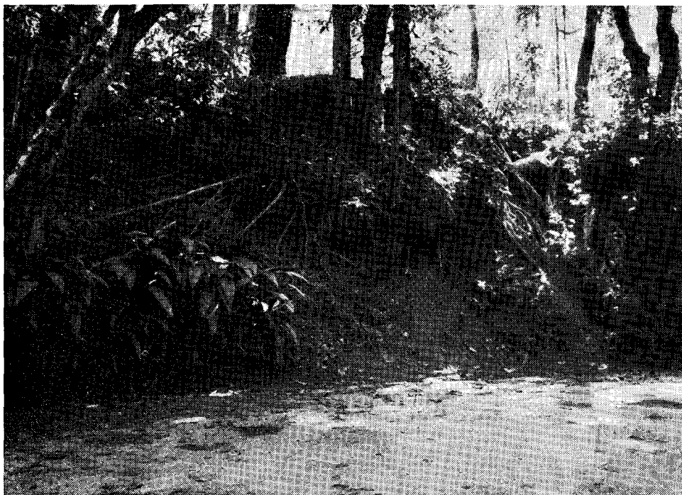
Fig. 10 — Desbarrancamentos na base dos cortes de estrada: observa-se maior solapamento abaixo das raízes
