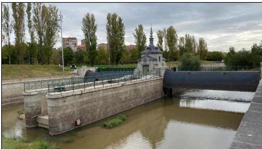
Figura 22 – Uso de barragem para controle de cheia do Rio Manzanares, em Madrid
