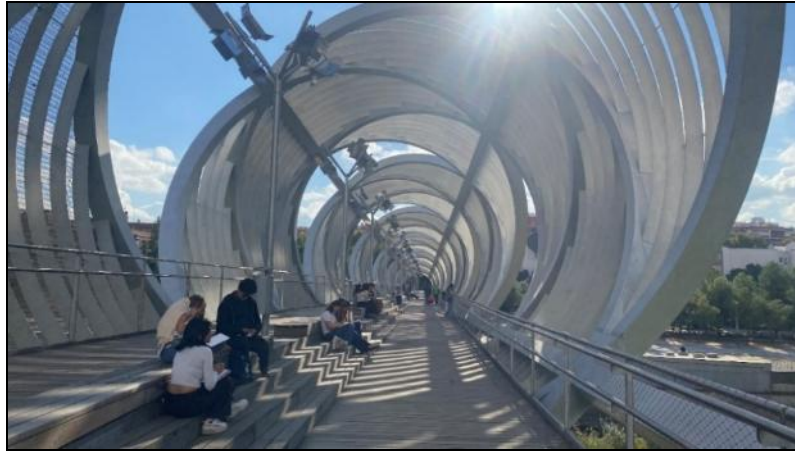
Figura 8 - Puento de Arganzuela, sobre o rio Manzanares, em Madrid Fonte: os autores (2024)
