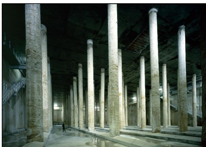
Figura 18 – Depósito subterrâneo de água pluvial do Parque Joan Miró, em Barcelona Fonte: Prefeitura de Barcelona.
