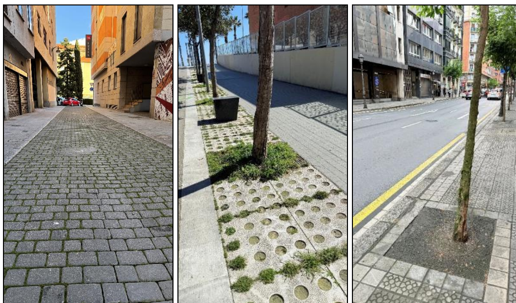
Figura 16 – Emprego de pavimentos permeáveis nas cidades de Valladolid (A), Barcelona (B) e Bilbao (C) Fonte: os autores (2025)
