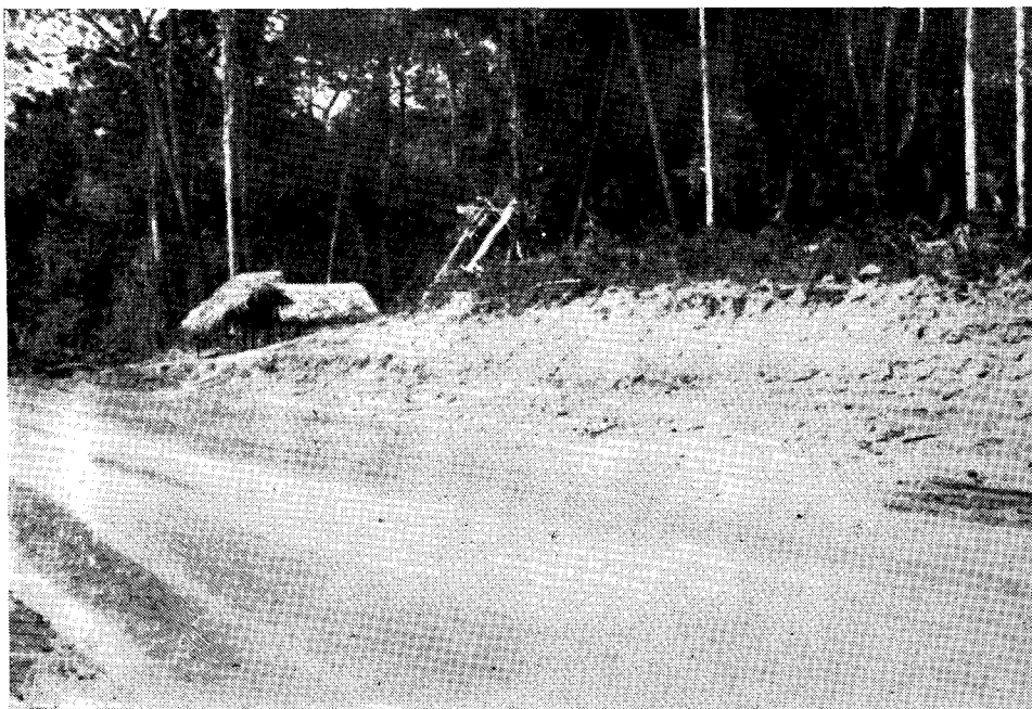
Foto 4 — Corte na estrada Humaitá-Lábrea, próximo ao igarapé Retiro, onde se vê um solo laterítico típico, profundo, friável, em que se instala a floresta amazônica.
