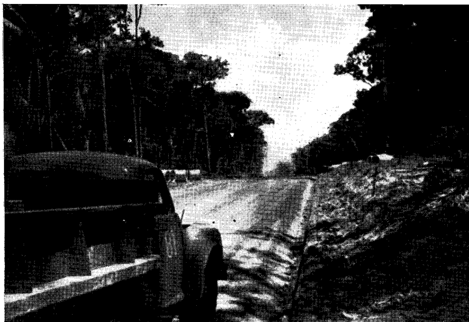
Foto 5 — Trecho da estrada Humaitá-Lábrea, avançando na direção do igarapé Ipixuna, em que são cortados solos lateríticos típicos, onde ocorre grande espessura de laterito.
