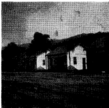
Foto 37 — Aspecto parcial da vila operária da secção Sete Barras. Mun. de Bocaiuva do Sul. (Foto Dr. Maia)
