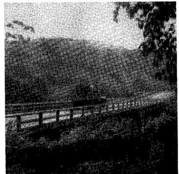
Foto 33 — Ponte de concreto sôbre o rio São Sebastião, para a secção Sete Barras do Núcleo Colonial Marquês de Abrantes. Mun. de Bocaíuva do Sul.
