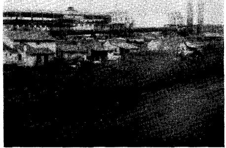
Foto 3 — Vista parcial da fábrica de cimento “Portland Rio Branco”, notando-se à direita as chaminés dos fornos de cimento, dos quais, no momento só o mais à esquerda está em funcionamento. As construções mais elevadas pertencem ao depósito “clinker” e as mais baixas do 1.º plano são algumas residências do pessoal da fábrica. A Cia de Cimento Portland Rio Branco, ocupa o 3.º lugar na produção no sul do Brasil (1.º Votorantim; 2.º Cerus, ambas com 4 fornos) e em breve, com o funcionamento do segundo forno, deverá destacar-se em 4.º lugar, entre as 22 fábricas de cimento em atividade no país.
