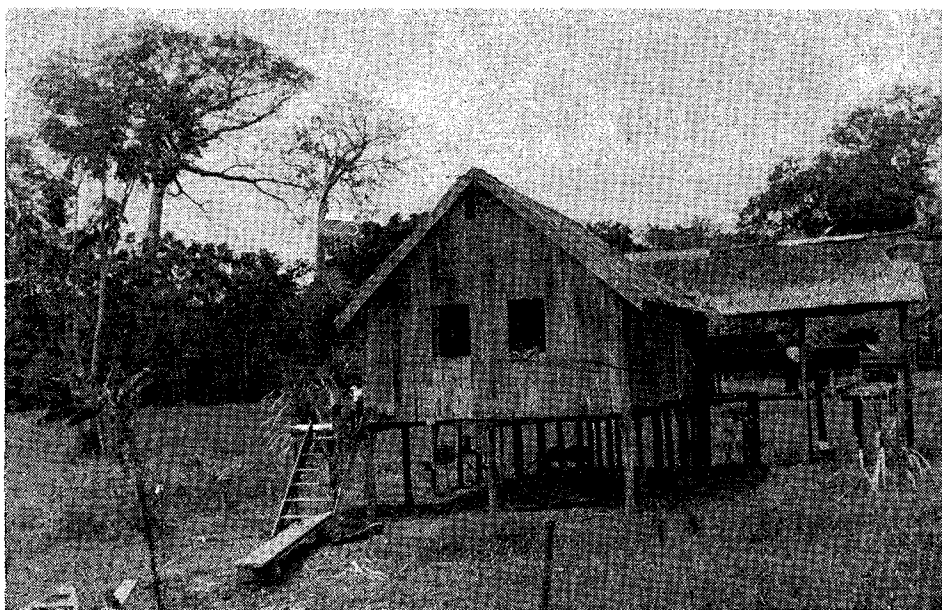
Fig 28 — Casa de madeira sòbre estacas altas, na "várzea" da margem direita do rio Negro, próximo da sua foz no Amazonas
