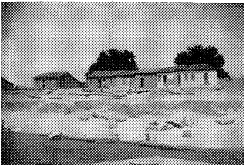
Fig. 21 — A vila de Pôrto Novo está situada sôbre terreno aluvial cenozóico, da série das Vazantes, que se mostra bastante nítida nas exposições dos barrancos com suas fácies flúvio-lacustres.
