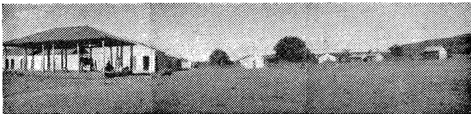
Fig. 32 — Vista parcial da localidade de Iuiu vendo-se o mercado, a praça central com as casas de alvenaria e os últimos contrafortes da serra calcárea.
