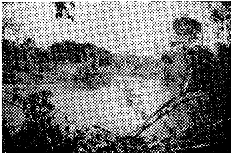
Fig. 13 — Desvio do rio Carinhanha causado pelo desmoronamento.
