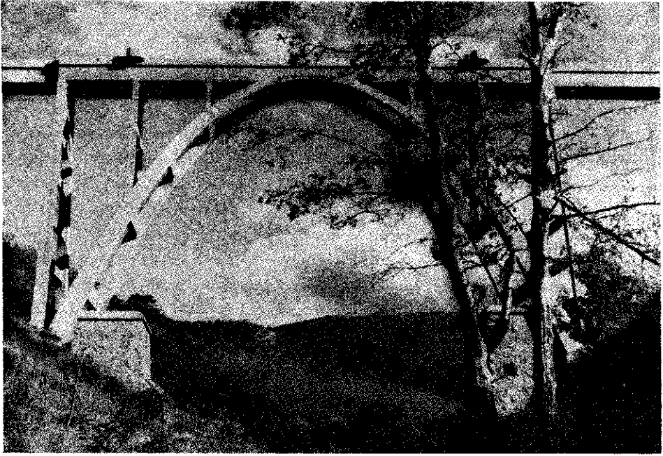
Fig. 13 — Outro aspecto do viaduto n.º 4
