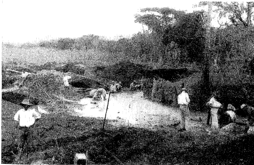
Região de Santa Rita Município de São João del Rei Aluviões de cassiterita no vale
