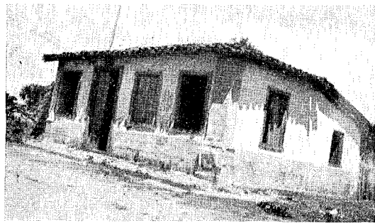
Uma das velhas casas de Corumbá, pois foi construída em 1876 Vai ser demolida, pois hoje se acha no eixo da avenida Cândido Mariano Note-se a falta de vidros nas janelas
