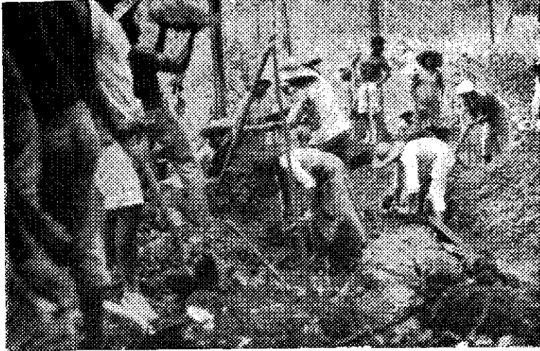
Um instantâneo do trabalho febril na exploração do ouro no Noroeste do Maranhão. O solo da mata, até quasi um metro de profundidade, é retirado avidamente e transportado pouco adiante para ser lavrado e apurado. Nessa fotografia, que apanha 19 pessoas, a maioria usa chapéu, mostrando a rudeza do clima. Há duas mulheres no trabalho, uma cavando e a outra transportando o material sobre a cabeça. A proporção de mulheres é da ordem de 10%. A mulher que está cavando é uma velha que há poucos dias havia encontrado uma enorme pepita
