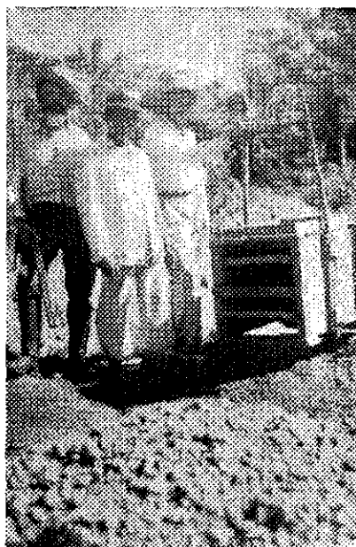
Um aparelho de lavagem de ouro, armado para funcionar. No chão, em frente, cascalho fino já lavrado e apurado. Vêem-se dois garimpeiros em trajes de repouso e o francês Camille Roy, companheiro de viagem do autor
