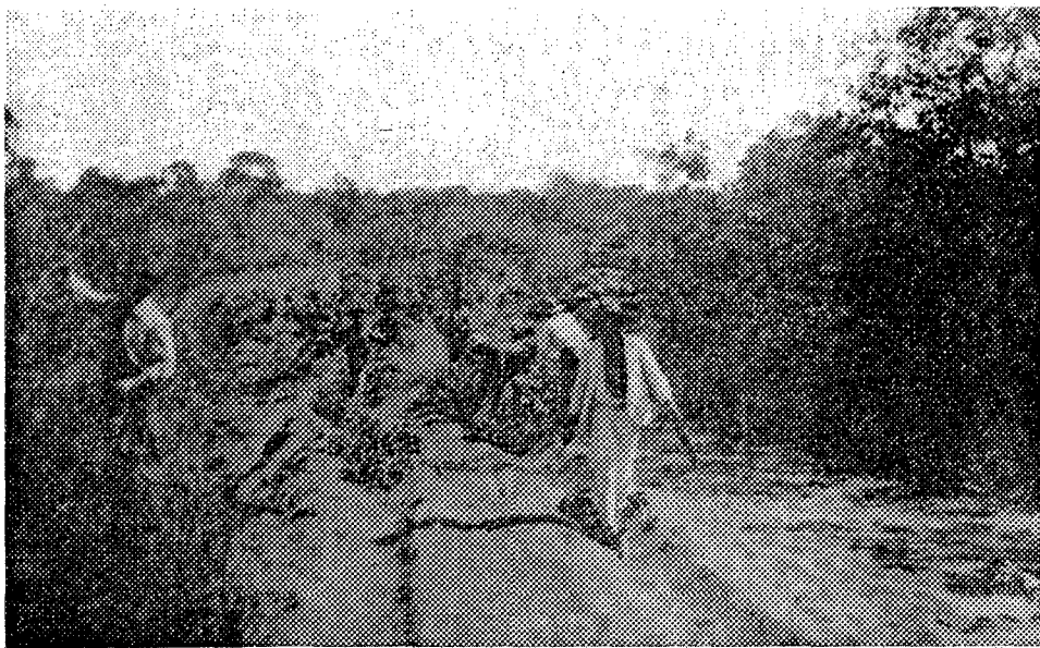
Aquí vemos um aspecto de nossa luta contra os enormes areões do território de Goiaz. Nesta ocasião estávamos nas proximidades da vila de Riachão, município de Posse
