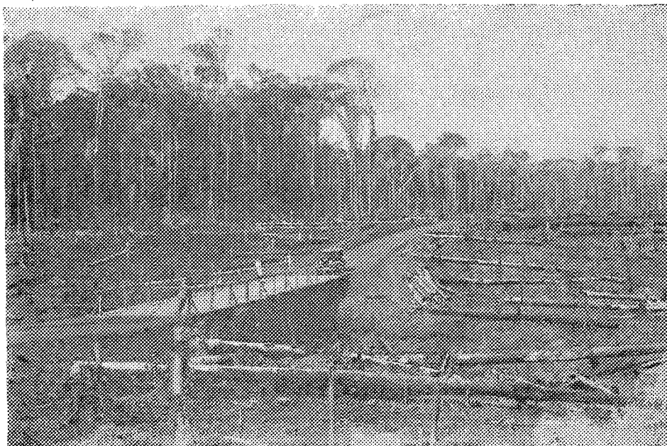
Trecho em construção da rodovia Pôrto Velho-Presidente Pena. Vê-se a derrubada e a floresta amazônica ao fundo
