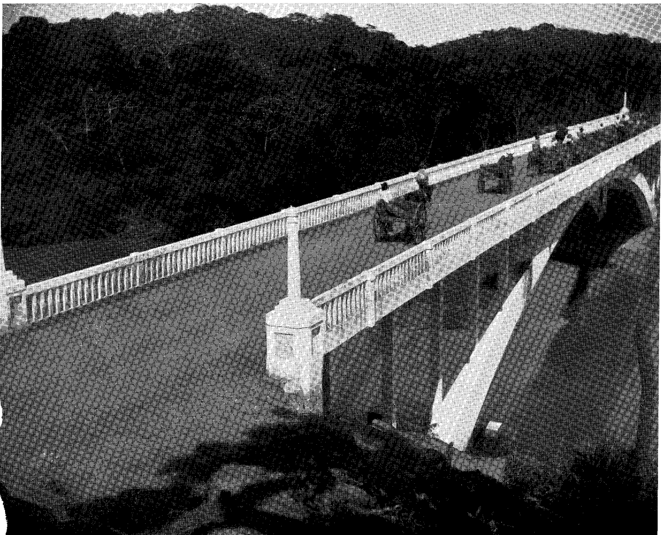
Estrada Rio-São Paulo — Ponte sôbre o rio "Guandú-Mirim", logo após sua construção
