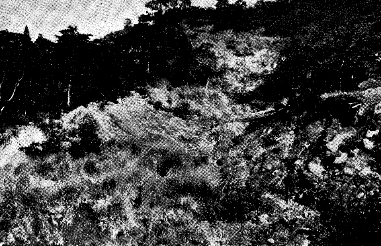
Fig. 5 — Estrada das Furnas: visão longitudinal do canal secundário, tomada a partir da sua junção com o canal principal. Observe-se a forma côncava acentuada das vertentes recém-formadas. Ao remover o material fino das encostas, o escoamento superficial posterior ao movimento de massa deixa aflorar blocos de tonalito.
