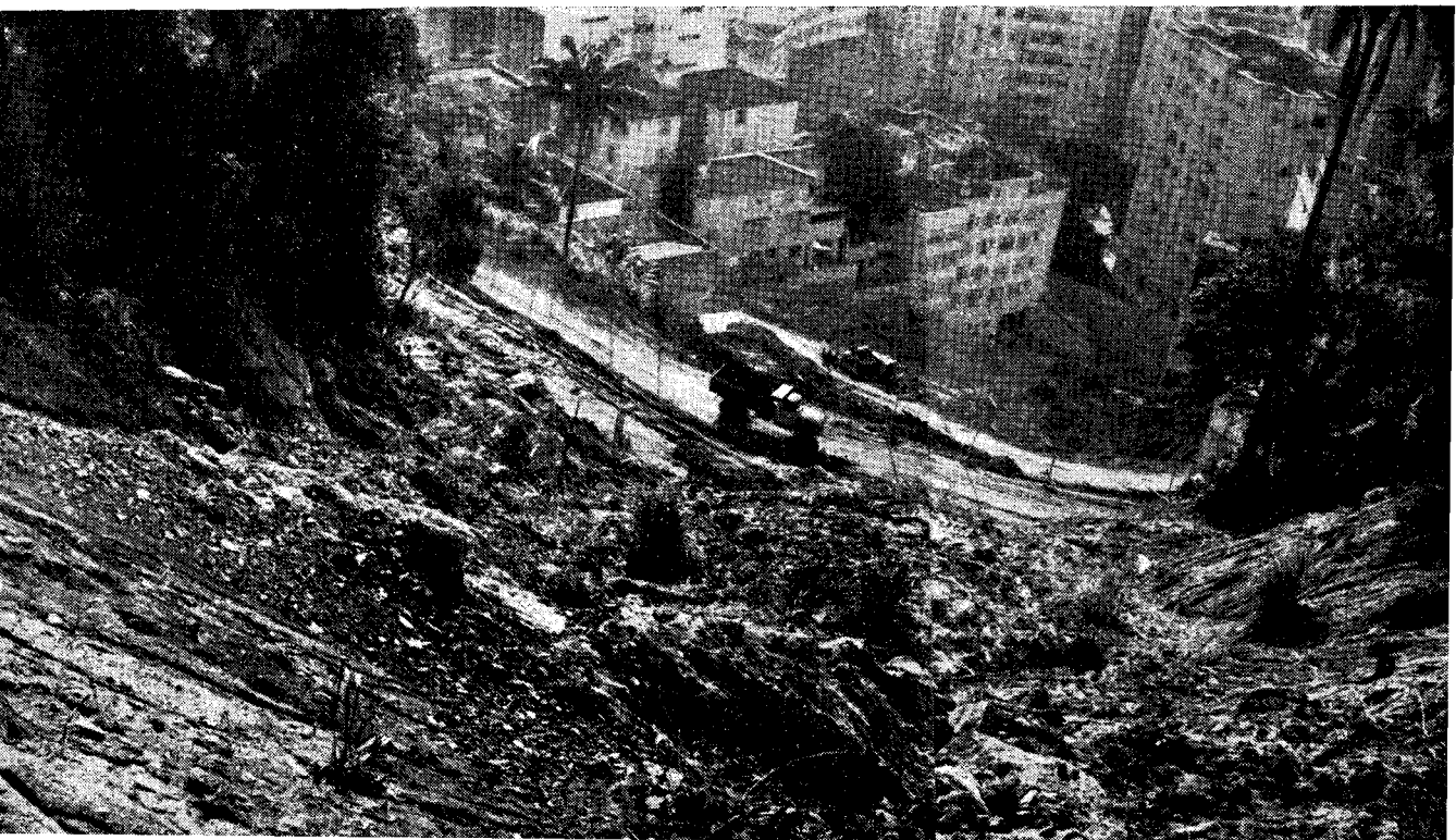
Fig. 10 — Rua Belisário Távora: visão geral da área atingida pelo deslissamento. A meia encosta, está sendo retrabalhada o antigo traçado da rua Belisário Távora. A foto foi tirada algum tempo após a ocorrência do movimento de massa, verificando-se que os seus detritos já foram parcialmente removidos.
