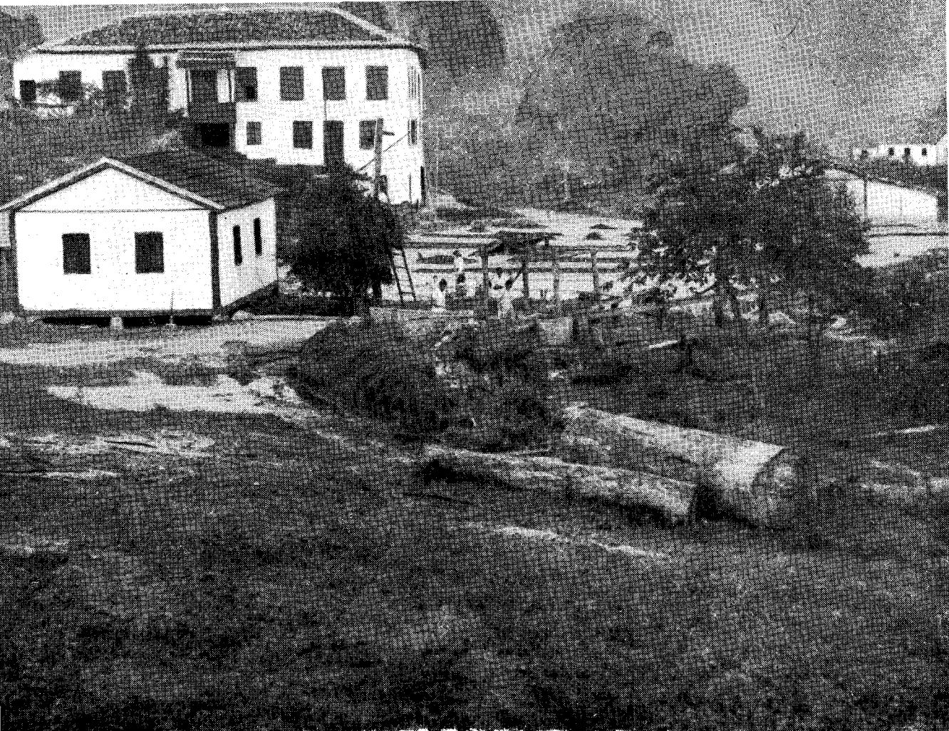
Foto 3 — Area de pequena propriedade de Limoeiro entre Castelo e Conceição do Castelo. A casa de maior dimensão que aparece nesta foto é representativa da 2.ª fase de ocupação do vale do Castelo e primeira da cultura do café. Trata-se de uma “casa grande” construída por escravos, na qual, residem hoje 4 a 5 famílias ligadas por laços de parentesco. A primeira casa do plano superior à esquerda (telhado de telhas do tipo francês) e a última do plano superior à direita são os exemplos mais característicos das residências dos colonos italo-brasileiros. O terreiro de café que aparece é utilizado em comum por vários proprietários. (Foto de OMAR GUIMARÃES).
