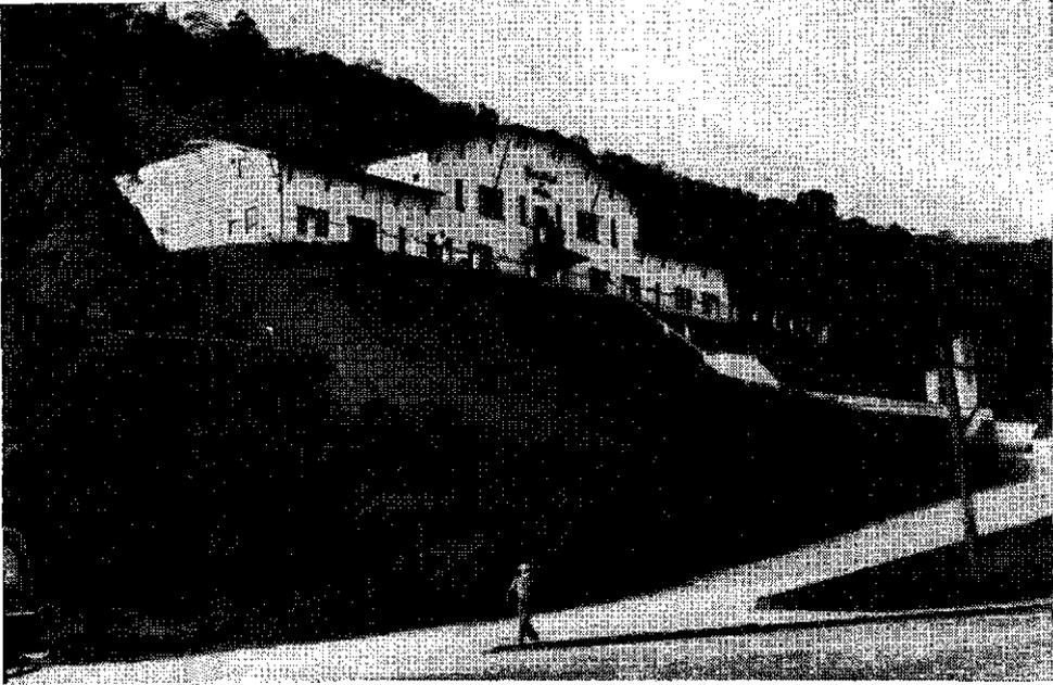
Fig. 5 — Fábrica no Bingen — A falta de espaço entre as encostas dos vales metropolitanos, explica os cortes feitos nas mesmas para abrir uma área plana, onde se constroem os novos estabelecimentos industriais como a da York Street, no bairro do Bingen. (Foto do autor).
