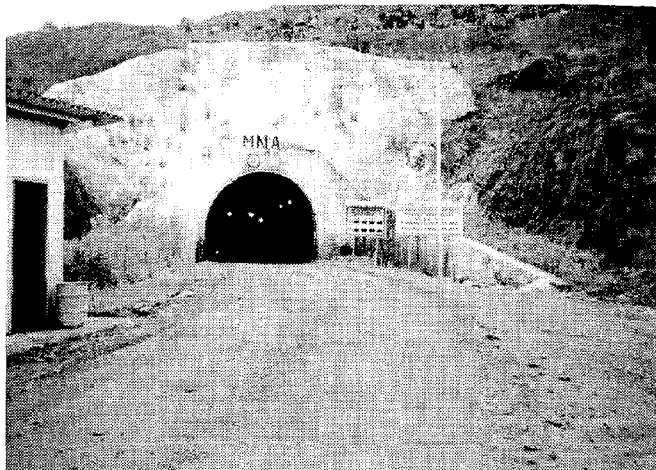
Foto 15 - Entrada da mina da mineração Novo Astro, na região do Lourenço (abr 1994)
