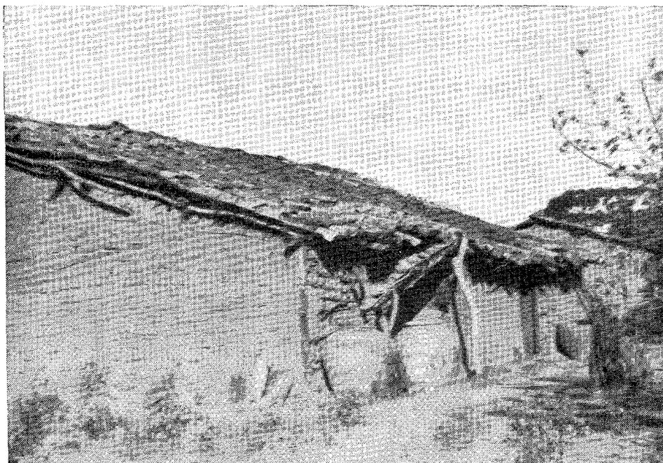
Fig. n.º 16 — Esta habitação modesta no sertão semi-árido de Alagoas reflete a influência do clima da região, pois, a calha é construída de tal maneira que a água da chuva que cai sobre o telhado é dirigida para grandes tinhas, a fim de ser aproveitada no uso doméstico.
