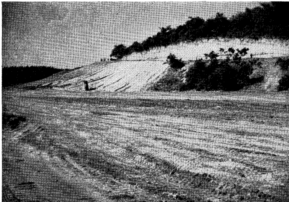
Foto 4 — Aspecto dos trabalhos de terraplanagem e abertura de ruas nos terrenos argilosos (nas argilas terciárias). Neste caso, trata-se de áreas de loteamento do Jardim Guanabara, junto à estrada do Galeão. (Foto N. Strauch).
