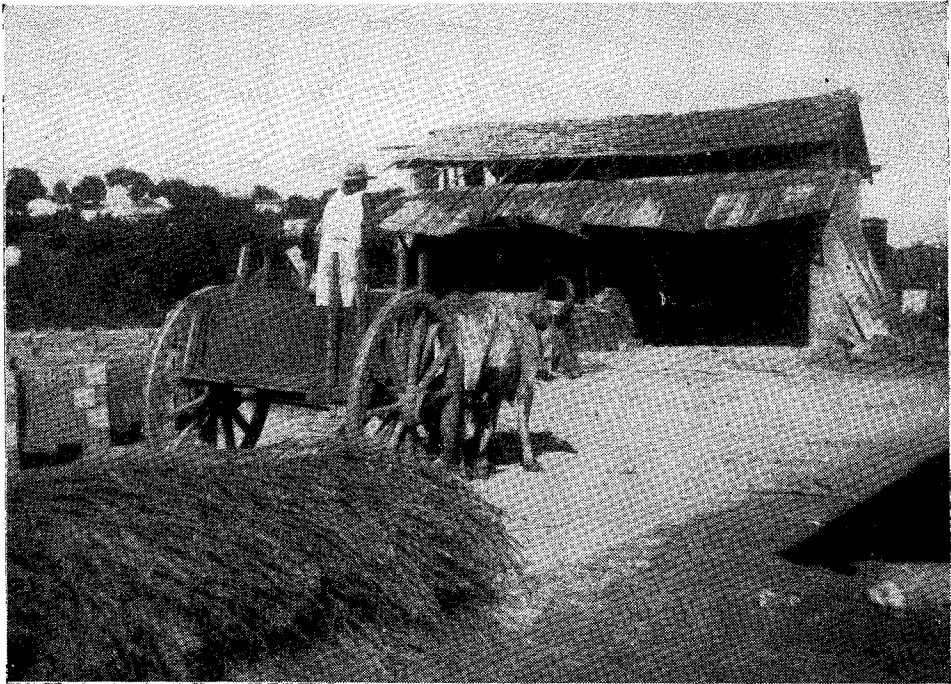
Foto 12 — Olaria “Fontinha”, Nilópolis. Vêem-se, em primeiro plano, à esquerda, os tijolos prontos para ir para o forno, notando-se a qualidade inferior do produto em relação ao da cerâmica de Mesquita. Em frente, pode-se observar a carroça puxada por um boi, onde são levados os tijolos até os lugares próximos, sendo usado o caminhão para as distâncias mais longas. É a carroça um dos meios de transporte comumente usado nas médias e pequenas olarias.
