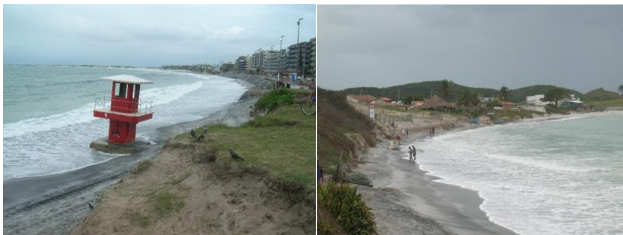
Figura 4. Praia do Forte após ressaca ocorrida no ano de 2010. Fotos: Kátia Mansur.
