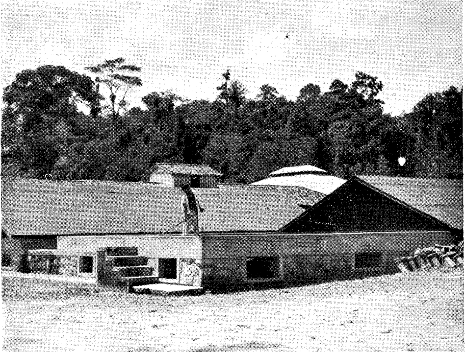
Fig. 10 — Estação Experimental de Uruçuca. “Mexendo o cacau” na barçaça. Operação necessária para secar o cacau por igual. A Estação Experimental recomenda que não se construam barçaças sobre habitações, para que as amêndoas não sejam afetadas pela fumaça dos lampêes de querosene, do fogão, etc.
