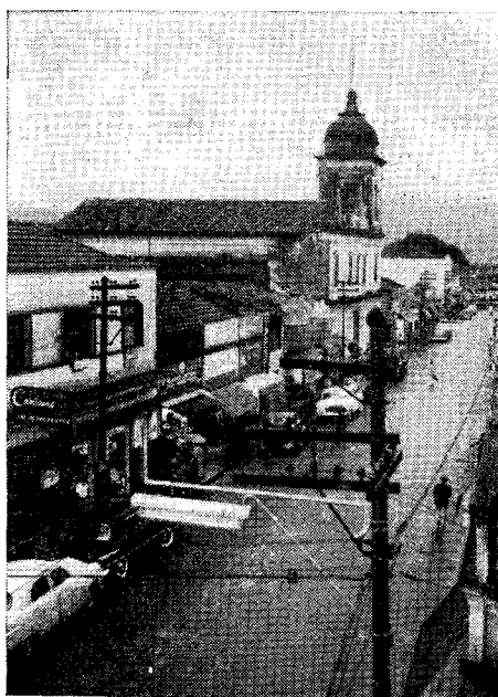
Fig. 30 — A rua Dr. Deodato Whertheimer é uma das mais antigas de Moji e se renova a cada lance de progresso da cidade. Compõe o quadrilátero central e abriga inúmeros elementos de uma ativa função comercial. (1958 — Foto do autor)
