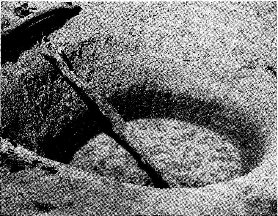
Foto 5 — O armazenamento da água no sertão semi-árido suscitou a criação de reservatórios variados, que aparecem comumente na região. Um dos mais simples é a "cacimba", isto é, um poço cavado no solo à procura dos veios d'água do lençol subterrâneo.
