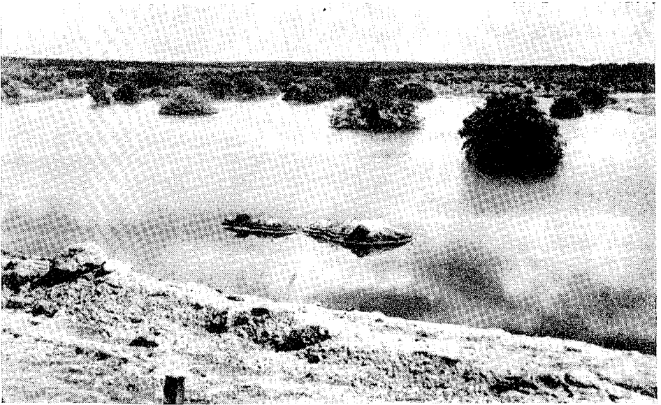
Foto 2 — Vista parcial do açude público Araras, situado no município de Reritiba no Ceará. Este açude é o de maior capacidade no sistema do rio Acaraú (um milhão de m 3 ); está em vias de adaptação para a produção de energia elétrica, com a construção já iniciada, de uma usina hidrelétrica. Sua construção data de 1951, terminada em 1958.
