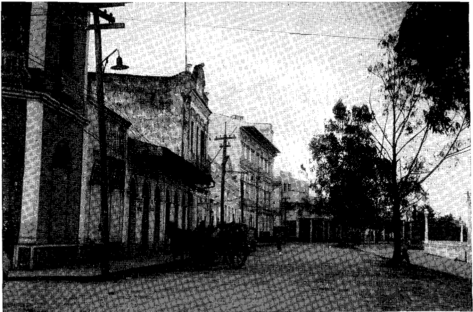
Fig 12 — "El Malecon", avenida que dá para o rio Amazonas que corre à direita da foto; os casarões do fundo foram construídos na época da borracha e são ocupados hoje, como as casas do primeiro plano, por lojas atacadistas de ferragens, cereais, etc. Há também vários escritórios do governo; ao fundo está o Hotel dos Turistas que faz parte de uma rede de hotéis do governo peruano
