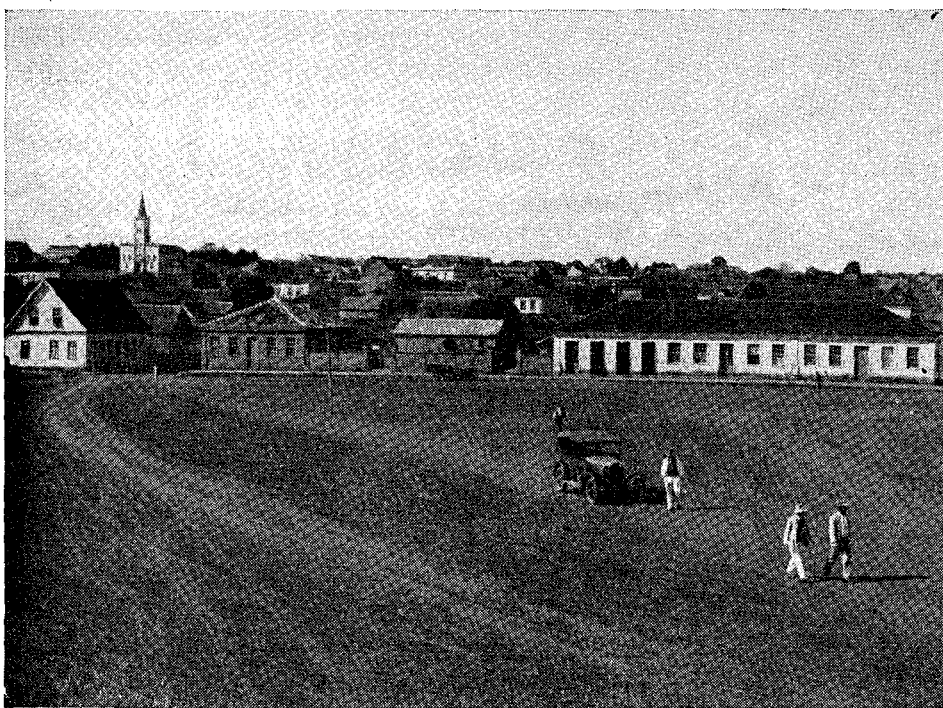
Foto 2 — Vista da cidade de Guarapuava, a mais antiga do terceiro planalto paranaense. Observa-se a diversidade dos tipos de habitações, testemunhando a mistura de raças que hoje se opera na velha cidade fundada pelos criadores paulistas. (Fototeca do CNG)
