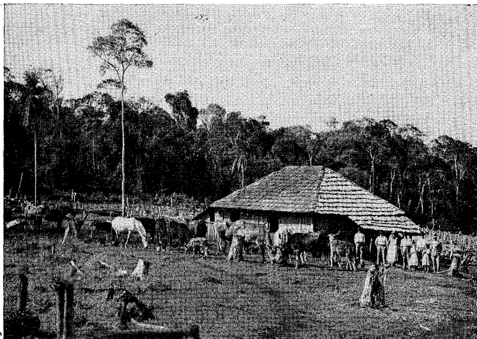
Foto 17 — Casa primitiva de um pequeno proprietário no município de Londrina, quando aí se achava a frente pioneira. A casa feita de palmito coberta de telhas de madeira, situa-se no fundo do vale. Depois de alguns anos, esta casa é usada como galpão sendo construída outra, mais conjorável.
