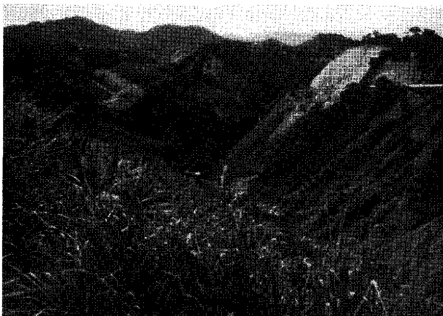
Foto 10 — Outro aspecto da ravina ao norte do Monumento Rodoviário, vendo-se à direita a pista de descida. Os fortes declives, a retirada da vegetação, a implantação da rodovia e as fortes chuvas foram os responsáveis pelos grandes deslizamentos nesta área.
