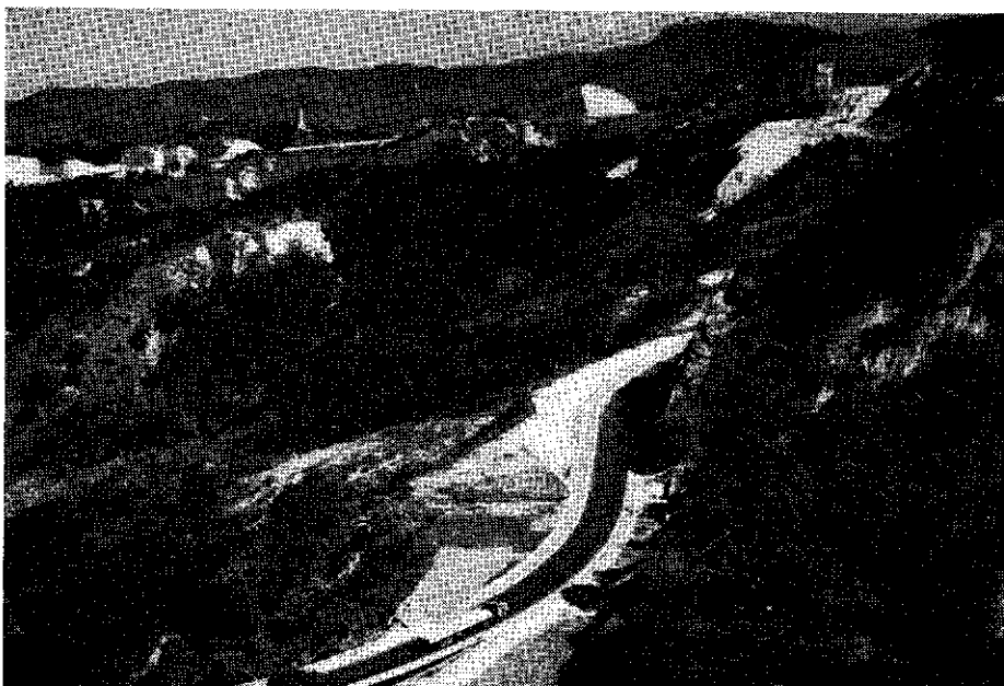
Foto 17 — Os cortes de estradas desprotegidos de vegetação e o material mal consolidado dos aterros favorece os deslizamentos em vários trechos da serra das Araras.
