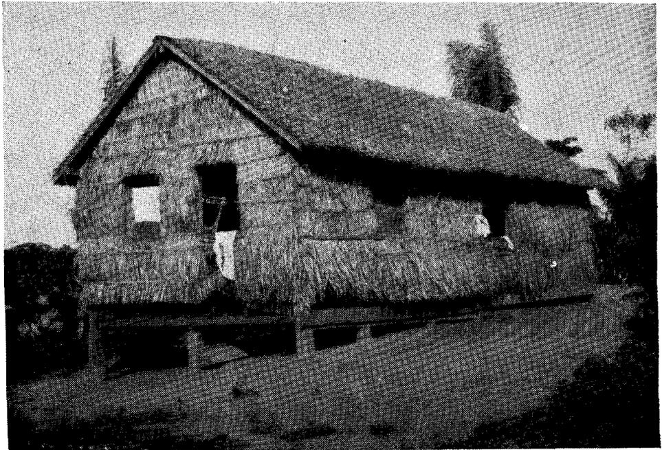
Fig. 12 — Casas construídas sem revestimento, inteiramente de fôlhas de palmeira, no bairro do Papoclo. Apenas a armação é feita de madeira.
