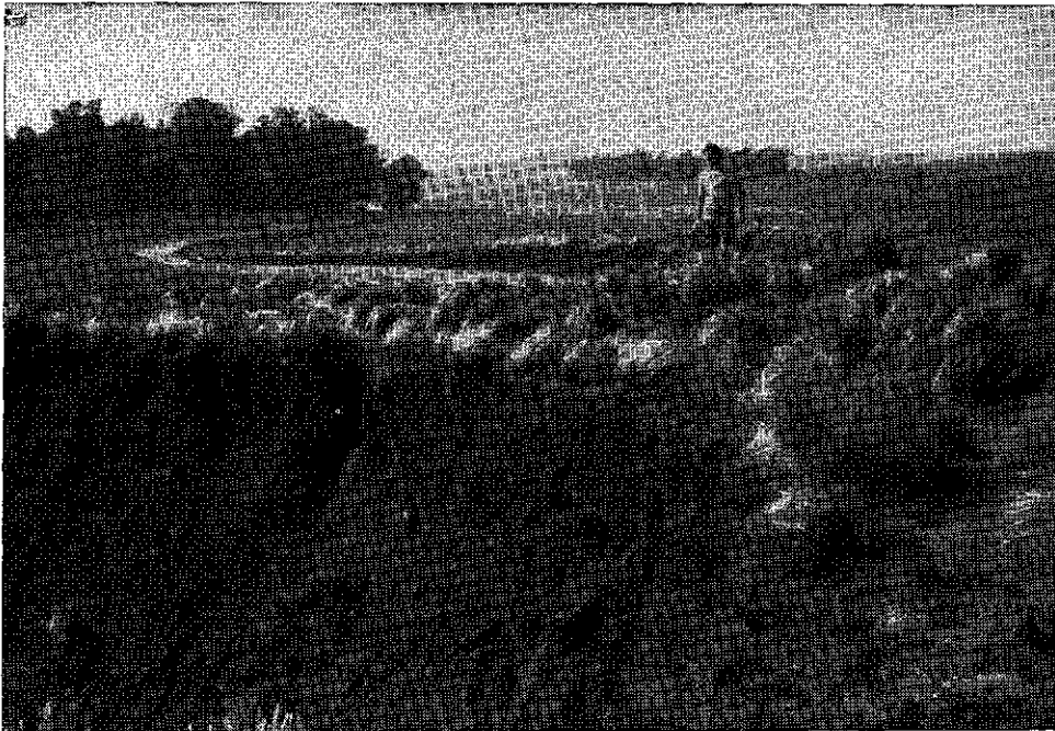
Foto 62 — Uma das frentes de erosão da voçoroca do Macaco Branco, atualmente inativa, encontra-se bem próxima (a menos de 10 metros) da estrada municipal que liga a cidade de Cacequi à vila de Umbu.
