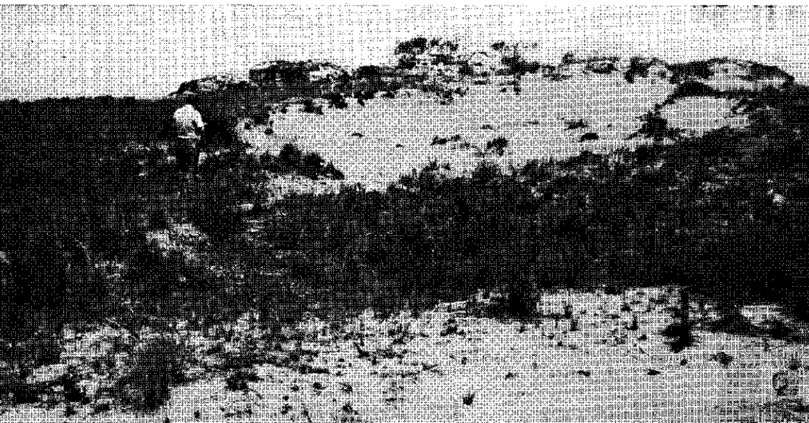
Foto 34 — Encosta do areal vista da rodovia RS-3. A completa destruição da vegetação campestre, já muito degradada pela erosão laminar e pelo pisotêio do gado, estenderá, por certo, o areal até a rodovia.
