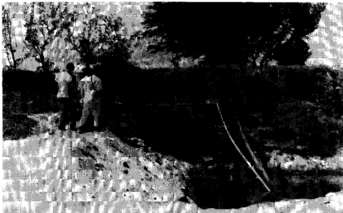
FOTO 5 - A motobomba diesel, aqui localizada abaixo mesmo do nível do "balcão", no leito do Taperoá, leva, para níveis mais altos, a água da cacimba escavada com pá. Observar, adiante da cacimba, as capineiras plantadas no leito seco do rio.
