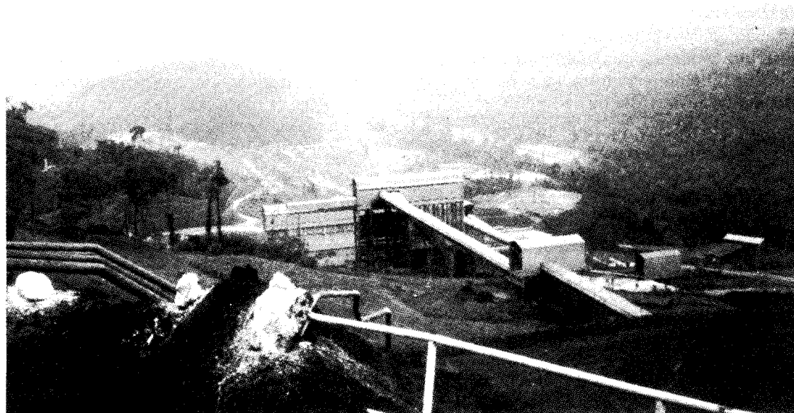
Foto 2 — Conjunto das unidades de beneficiamento do Projeto Ferro Carajás, da Companhia Vale do Rio Doce, da britagem secundária à pêra ferroviária. Observe-se o recobrimento vegetal, desde a floresta natural aos taludes plantados, em toda a extensão da área.
