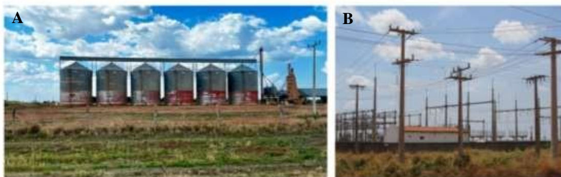
Figura 3: A – Vista de silos de armazenagem de grãos observada da estrada de Mateiros (TO) a Formosa do rio Preto (BA). Foto: T.M. Silva (out./2023). B – Objetos componentes da rede elétrica que atende às atividades do agronegócio na região observados na estrada de Formosa do rio Preto (BA) a Luís Eduardo Magalhães (BA). Foto: A. Brasil-Machado (out./2023).
