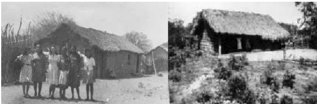
Figura 20: Casa típica de pau a pique, o barro batido e a casca de piaçaba de veredeiros na localidade de Boqueirão, onde os rios Preto e Grande se juntam. Fotos: Eng. G. S. Pereira (set./1943).
