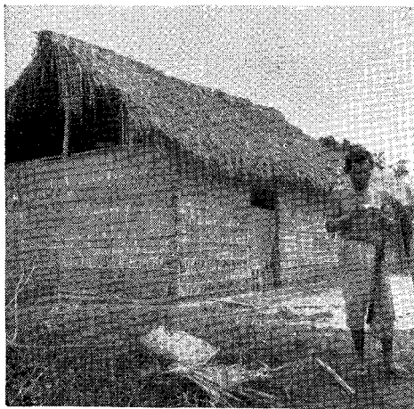
Fig. 18 — Casa tóda de palha de babaçu, de um caboclo de Lagoa, perto de Bacabal. (Foto Orlando Valverde)
