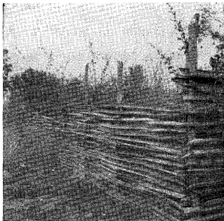
Fig. 21 — Cerca de talos horizontais de fôlhas de babaçu, em Lagoa, perto de Bacabal. (Foto Orlando Valverde)
