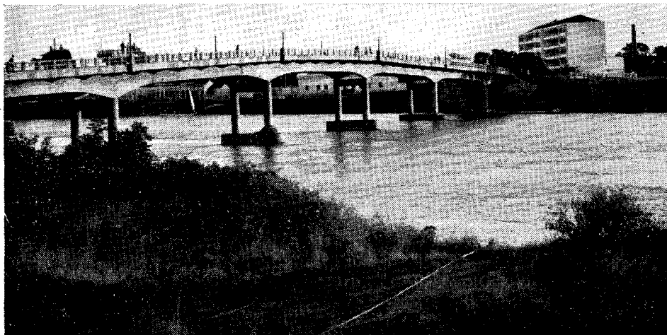
Foto 4 — Na baixada campista é bastante acentuada a amplitude entre os níveis da vazante e das cheias do Paraíba do Sul. Se na vazante, como ilustra a fotografia, o Paraíba mostra-se perfeitamente calibrado no seu leito, nas cheias ele, não raro transvaza-o, inundando a baixada, com sério perigo para as populações locais.
