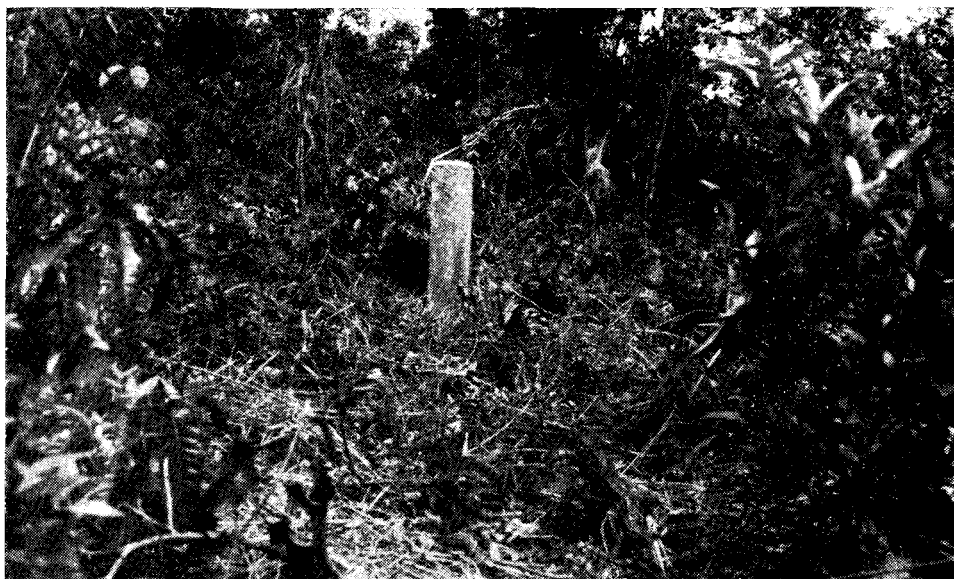
Fig. 3 — Marco na chã do Berenguer aos 70,3 m de altitude; ponto de trijunção de limites dos municípios de Olinda, Paulista e Recife.
