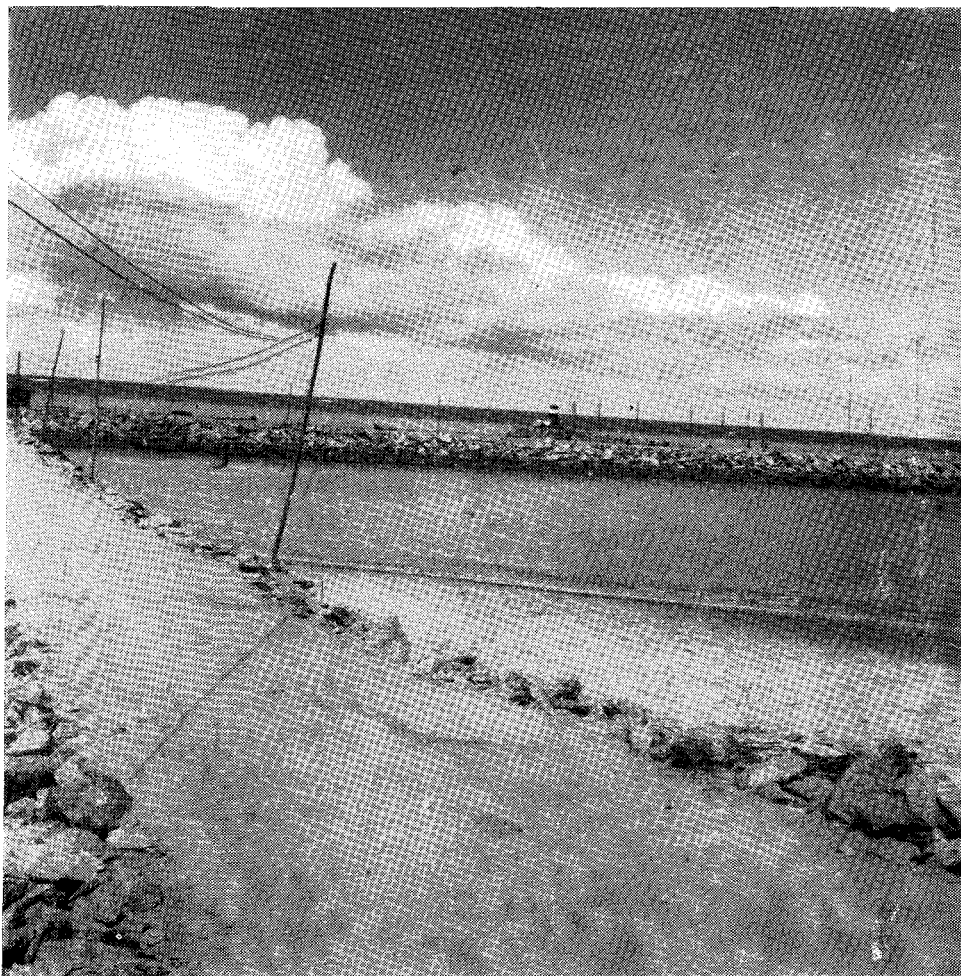
Fig. 4 — Aspecto do trecho inicial das obras de proteção às praias de Olinda, localizado na destruída praia do Carmo.
