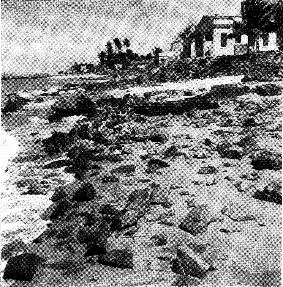
Fig. 14 — Expressivo aspecto da destruição pelo mar, das praias de Olinda, no trecho denominado São Francisco.
