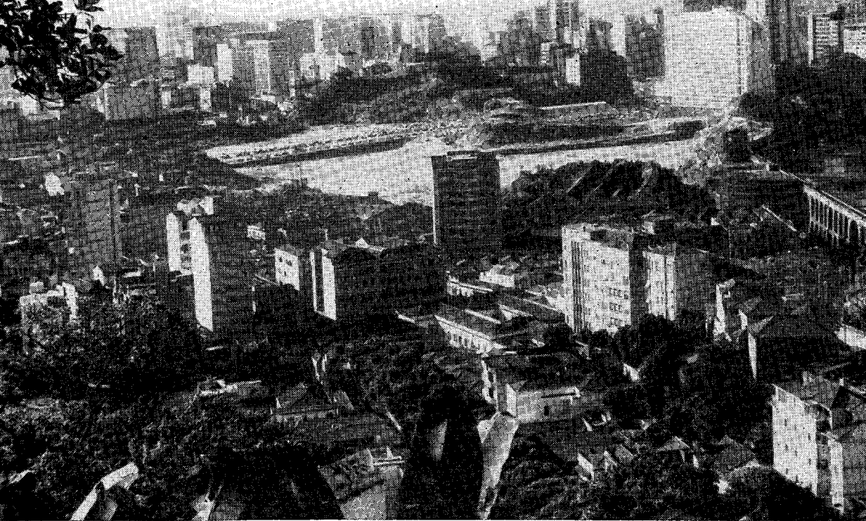
Fig. 11 — O morro de Santo Antônio constituía um limite natural à expansão do centro do Rio de Janeiro, impedindo seu crescimento na direção da área de deterioração do setor Inválidos-Lavrado e da Lapa. Seu desmonte veio abrir a última frente da expansão interna do espaço urbano. (Foto C.N.G. Chagas)
