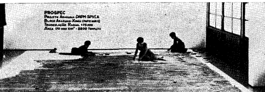
Fig. 7 — Aspecto da triangulação radial, em que se vê o assentamento dos cartões ranhurados, na parte setentrional do painel Xingu-Araguaia. o bloco ilustrativo corresponde a uma área de 170 000 quilômetros quadrados.
