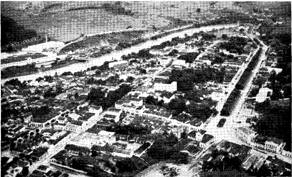
Foto 14 — Pela foto podemos observar o grande contraste entre a largura do terraço da margem esquerda com a da margem direita do rio Pomba. Enquanto no primeiro, mais largo, foi possível maior expansão da cidade, no segundo, a largura, reduzida possibilita somente a existência de uma única rua, com casas construídas de um só lado (na sua maior extensão).
