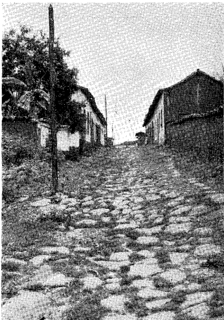
Fig. 9 — A principal rua da velha e decadente cidade de Diamantino, no norte mato-grossense. Note-se o traçado irregular da rua e o calçamento primitivo em pé de moleque. Foto Faludi
