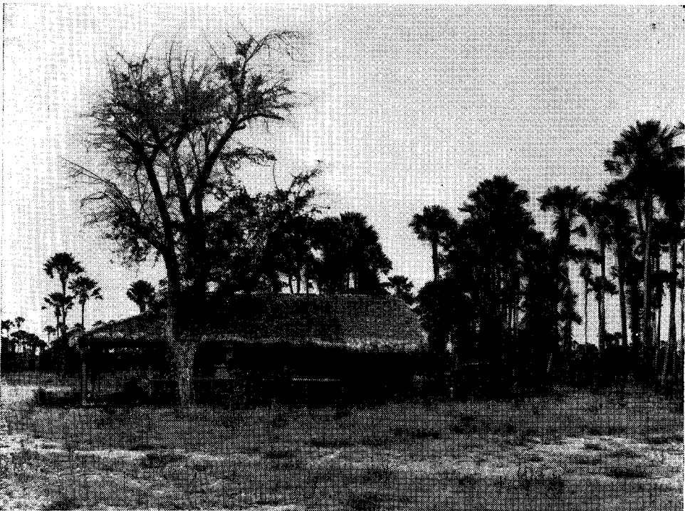
Fig. 5 — Aspecto do “perrechil”, a 3 km ao norte de Camboeiro. Barracão de paredes de sopapo e coberto de palha, residência típica de moradores e meeiros, danificado pela enchente.
