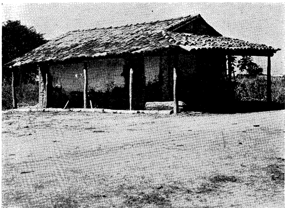
Fig. 11 — Prédio de “usina” de cêra de carnaúba, em Santo Antônio. (Foto Orlando Valverde, 9-7-60)
