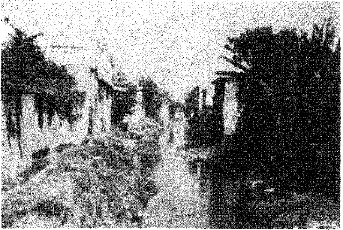
FOTO 5: Município de Paracambi. — Rio dos Macacos — corpo receptor de esgotos.
