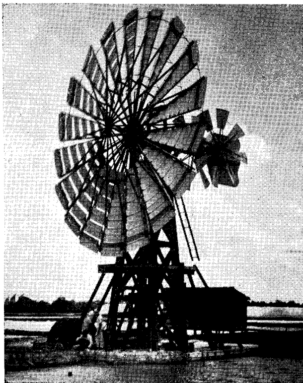
Foto 1 — O moinho de vento ou "catavento" utilizado, em várias salinas, para a captação da água do mar, é um dos elementos típicos da paisagem salina. (Foto do INS).
