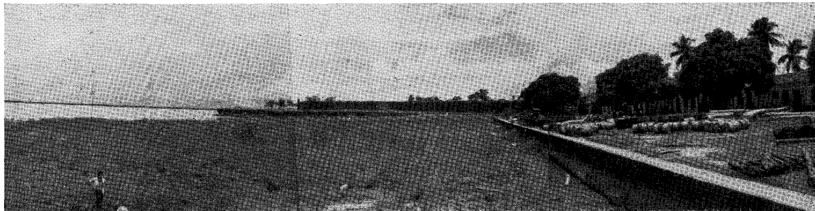
Fig. 35 — Remanso ao sul (montante) do trapiche de Macapá, mostrando a grande área que é coberta diariamente duas vezes, pela maré. O nível das águas do Amazonas alcança, no paredão, a altura limitada pela faixa mais escura. A vegetação, tolerante às imersões periódicas, está radcada a um solo de vasa, se bem que resistente. Ao fundo a histórica Fortaleza, vendo-se também a falésia que a ameaça. (Foto CLAUDE P. COURBET).
