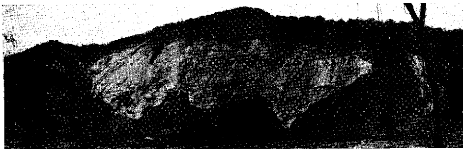
Fig. 10 — Um dos maiores escorregamentos ocorreu na face sudeste do morro do Jaraguá, fazendo aflorar os gnaisse e soterrando parcialmente taludes de detritos mais antigos. Nota-se à esquerda a espessura do manto de alteração.
