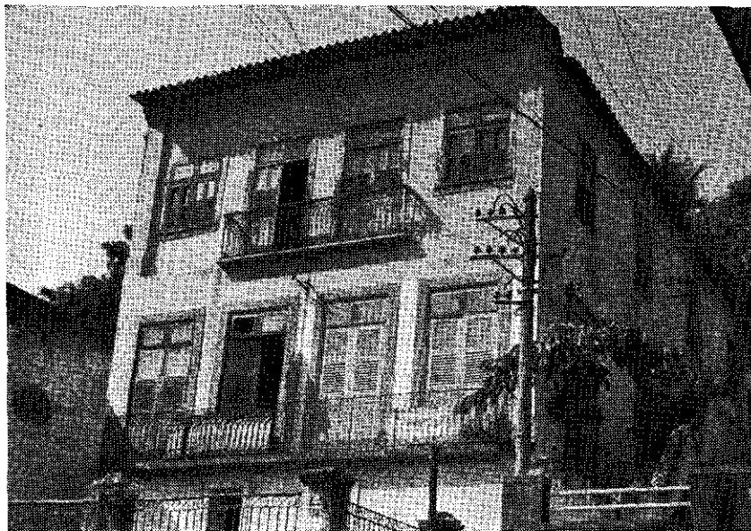
Foto n.º 22 — Casarão transformado em cortiço, na Rua Paula Mattos. Como é próprio do lado par desta rua, as edificações fizeram-se do plano da calçada para cima, ocupando, como se vê na foto, três andares.
