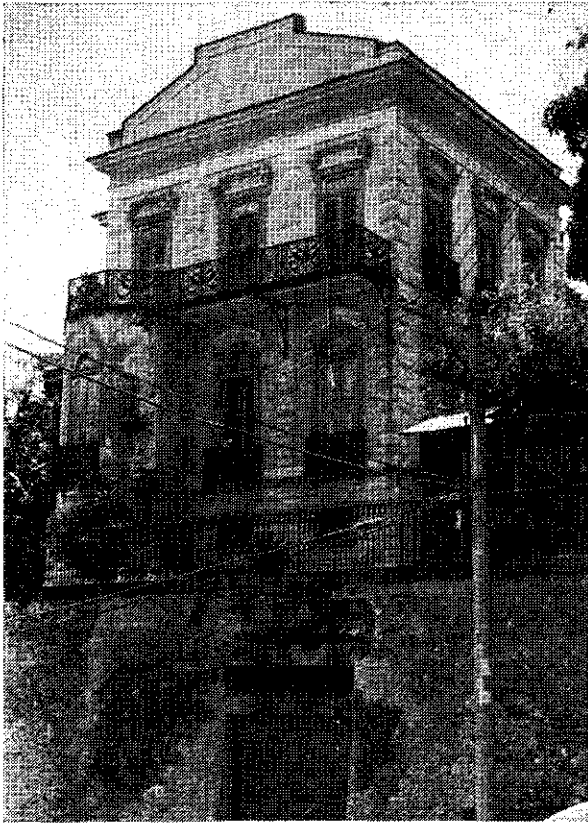
Foto n.º 11 — Solar na rua Costa Bastos, construído de pedra e ferro. Transformado em cortiço, hoje encontra-se em restauração para ser utilizado com finalidade comercial.
